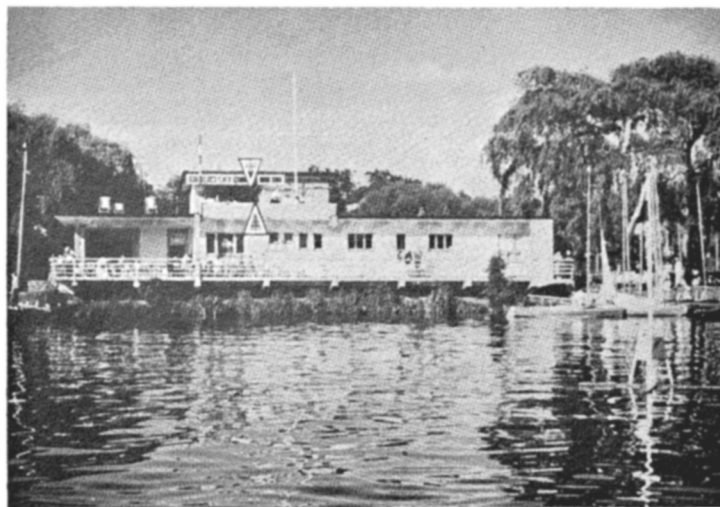
Das Clubhaus des „Ruhrland“ am Baldeneysee in Essen-Heisingen
