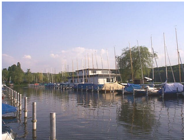
Der Hafen nach dem Umbau
