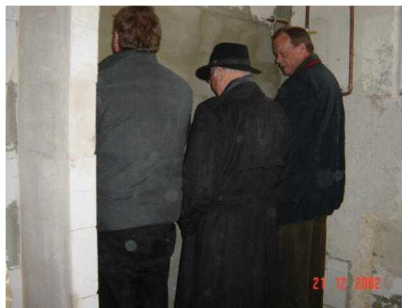
Bauunternehmer und Hafenwart Wiegers, Architekt Stiens und Schatzmeister Döbbeler testen im Rohbau die Größenverhältnisse auf der Herrentoilette
